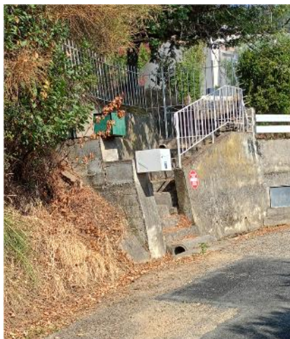
Escalier de M. NYKIEL PHOTO EP
