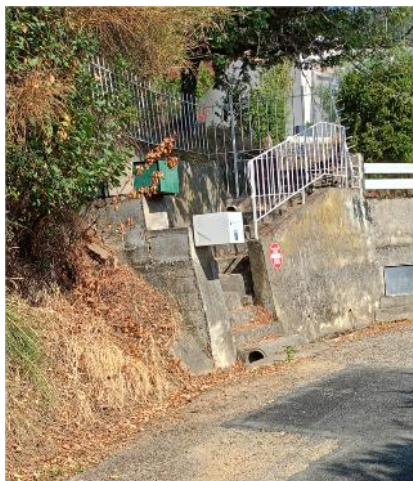
Escalier de M. NYKIEL PHOTO EP
