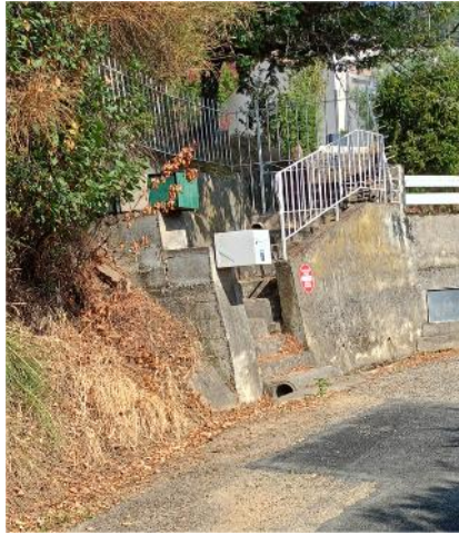
Escalier de M. NYKIEL PHOTO EP
