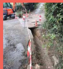
Nettoyage du fossé et remplacement de la buse bouchée Montée du Serre
