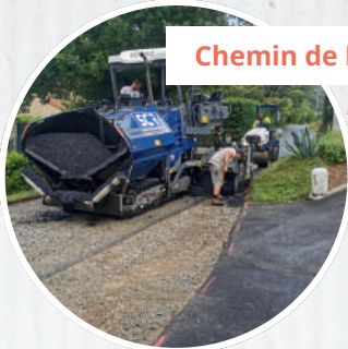
Réalisation d'un enrobé
