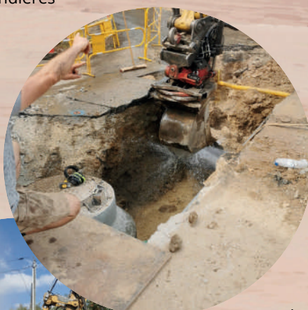
Travaux de séparation des eaux pluviales et des eaux usées Montée du Serre (partenariat CCRC) et changement des canalisations de d'eau potable (partenariat avec le syndicat Ayguo)
