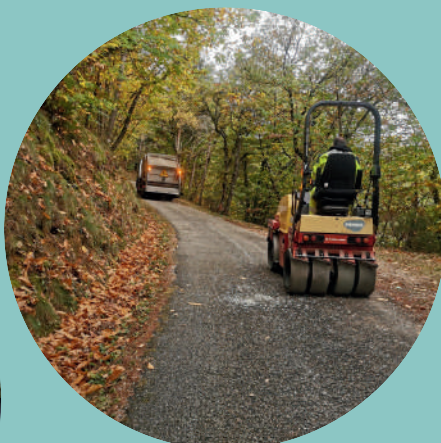
Gondronage d'une partie du Chemin d'Entreilles
