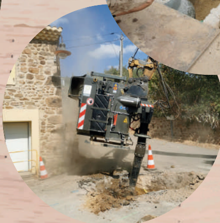
Travaux de séparation des eaux pluviales et des eaux usées Montée du Serre (partenariat CCRC) et changement des canalisations de d'eau potable (partenariat avec le syndicat Ayguo)
