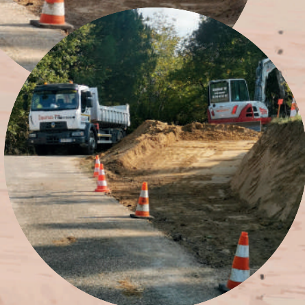
Profilage et remise en l'état d'un chemin - Quartier Vitaterne
